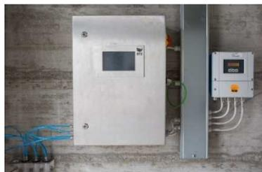
*Analyseur de Biogaz en continu BTS Biogaz (% $CH_4$  / %  $H_2S$  / % $CO_2$  / % $O_2$ )*
